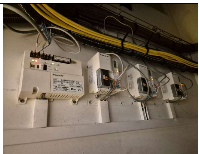
Passerelles d'extension des DRV placées dans la gaine CFO -B6-7-8
